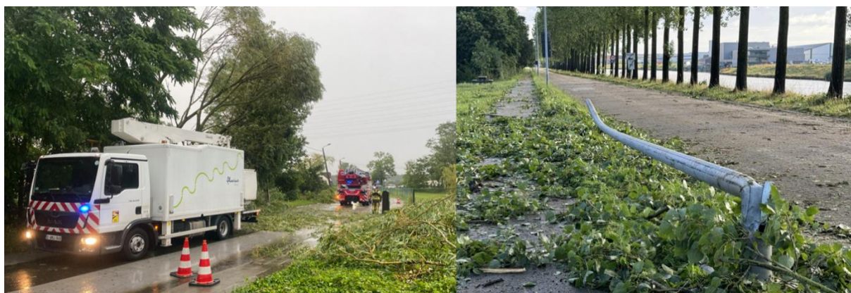
Voorbeelden van schade aan luchtlijnen en openbare verlichting.
