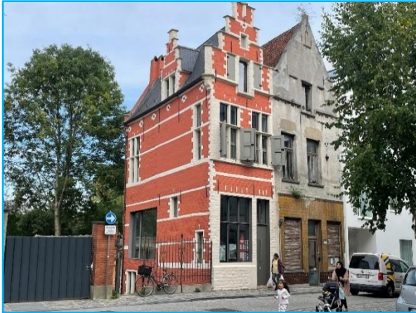
Foto 1 - Voorgevel pand Den Witten Engel (woning rechts)
