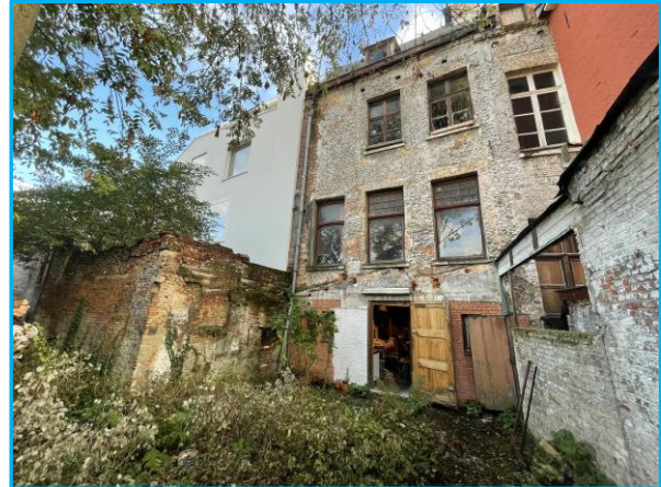
Foto 2 - gevel achterhuis Den Witten Engel (zicht vanuit de Melaan)
