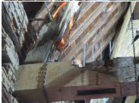
Restauratiewerken aan de houten dak- en vloerconstructies.
