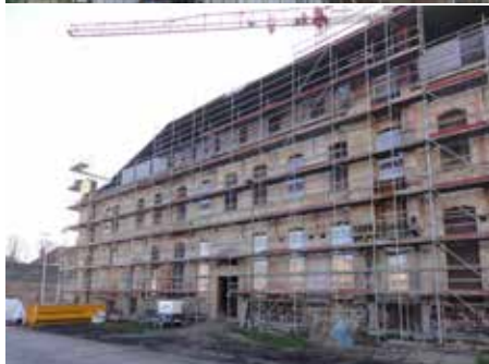
Stellingen aan de oost- en noordgevel. ©Callebout-architecten
