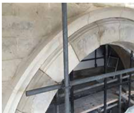
Dit detail van een gerestaureerde vensteropening toont de combinatie van nieuwe natuursteen (witte tint) met behouden natuursteen, die met restauratiemortel werd bijgewerkt (grijze tint).
