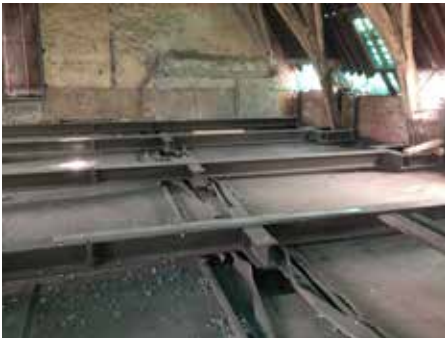
Versteving van de dakconstructie met een overkoepelende staalconstructie. ©Callebout-architecten
