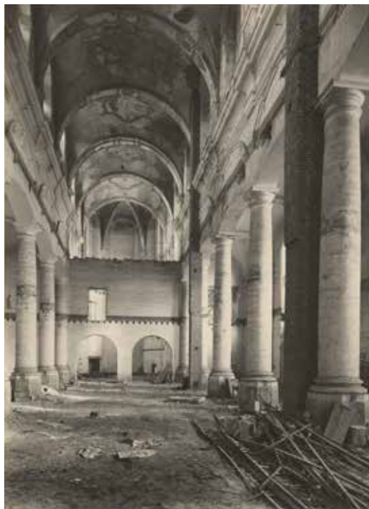
De 19de-eeuwse tussenniveaus in de midden- en zijbeuken van de kerk verdwenen na een brand in 1946. De tussenmuurtjes met sporen van draagbalken op deze foto geven aan op welke hoogte de afgebroken niveaus zich bevonden.
