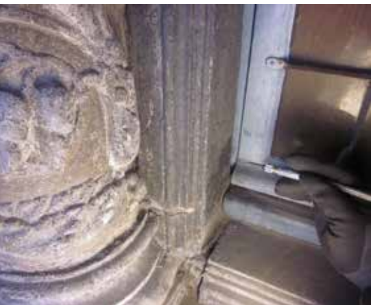
Tot op de 19de-eeuwse laag: de afwerklaag op de blauwe hardsteen wordt blootgelegd door een microstraaltechniek onder lage druk met holle glaspereels.
