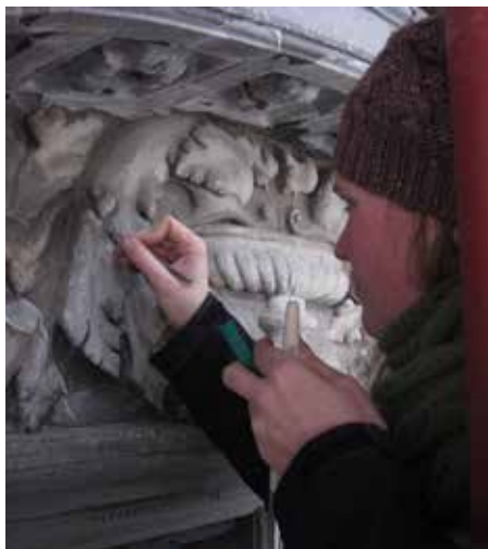
Tot op de 19de-eeuwse laag: de verflaag op het beeldhouwwerk van Avesnessteen (krijtsteen) wordt blootgelegd met een scalpel en/of glasvezelstift.
