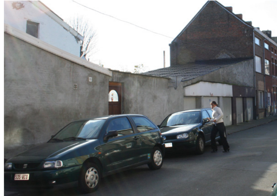
BLINDE- OF DOOR GARAGEPOORTEN GEDOMINEERDE GEVELS BEPALEN HET BEELD
