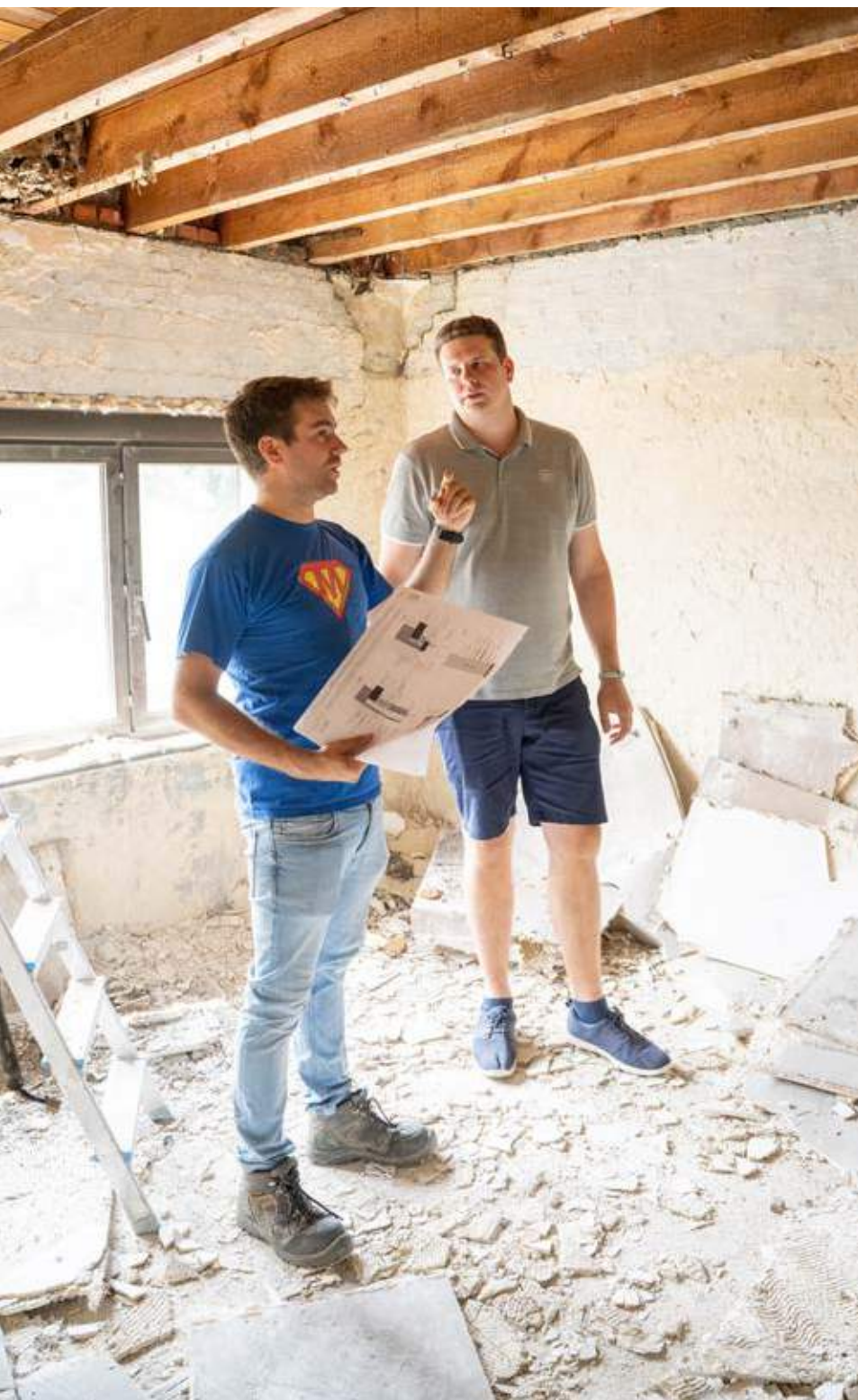
Een renovatiecoach kan langskomen om je huis door te lichten en je op meerdere vlakken te ondersteunen.
