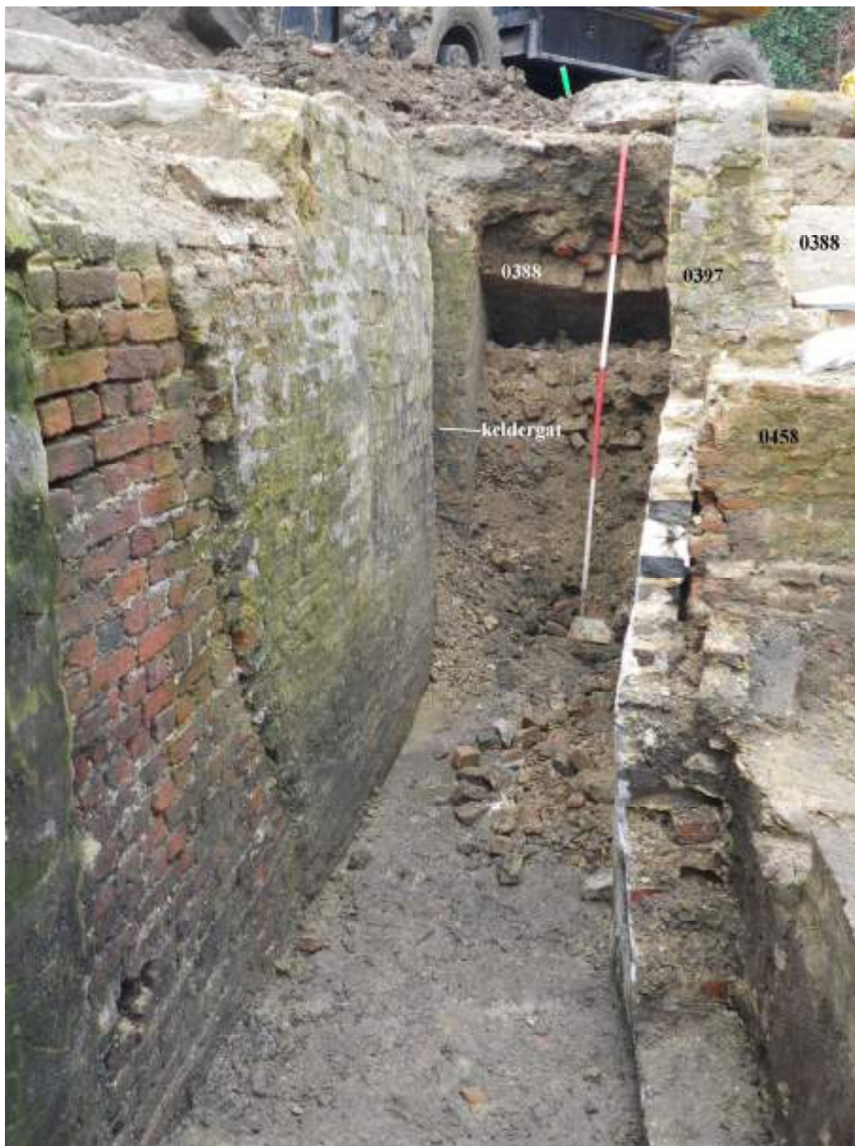
Figuur 3.3.7-9: zicht vanuit de gang op de achterste kelder, gezien vanuit het noorden
