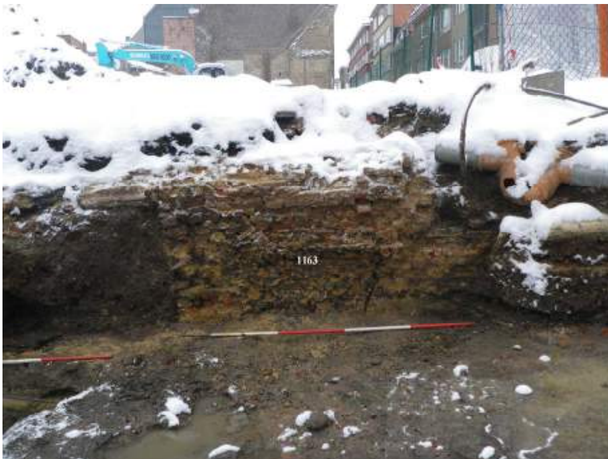
Figuur 3.3.5-175: keldermuur 1163 in werkput 4, gezien vanuit het noorden
