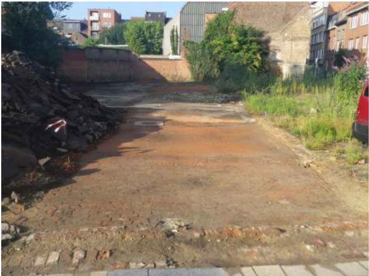
Figuur 3.3.7-53: niveau 0 opgekuist na verwijdering van asfalt
