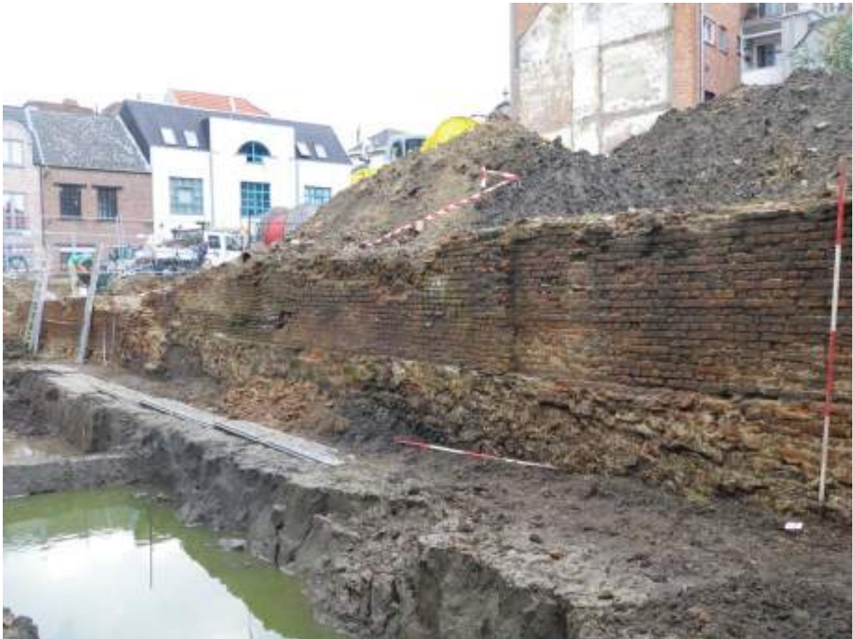
Figuur 3.3.5-195: muur 0060, gezien vanuit het zuidoosten van werkput 1.
