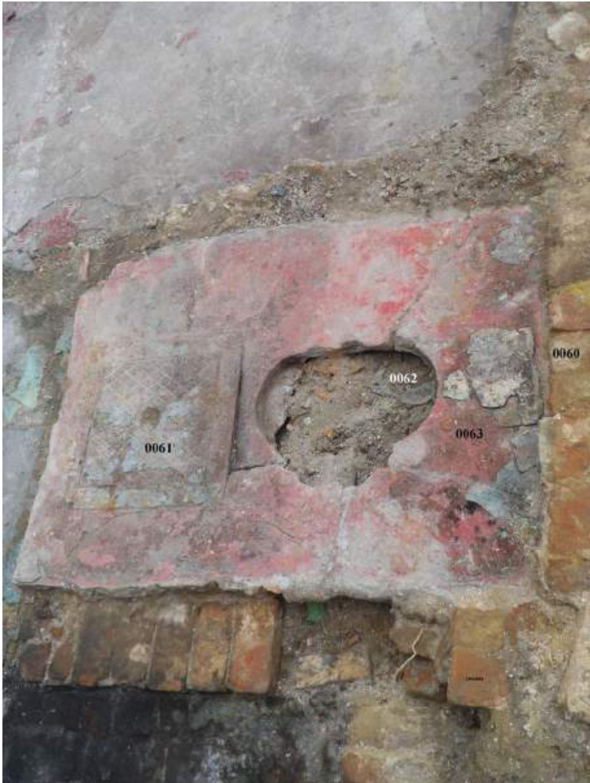
Figuur 3.3.7-88: wc-vloertje, gezien vanuit het zuiden
