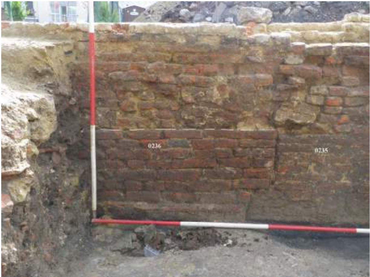
Figuur 3.3.5-9: muur 0236 (onder witte stippellijn), gezien vanuit het westen (werkput 1)
