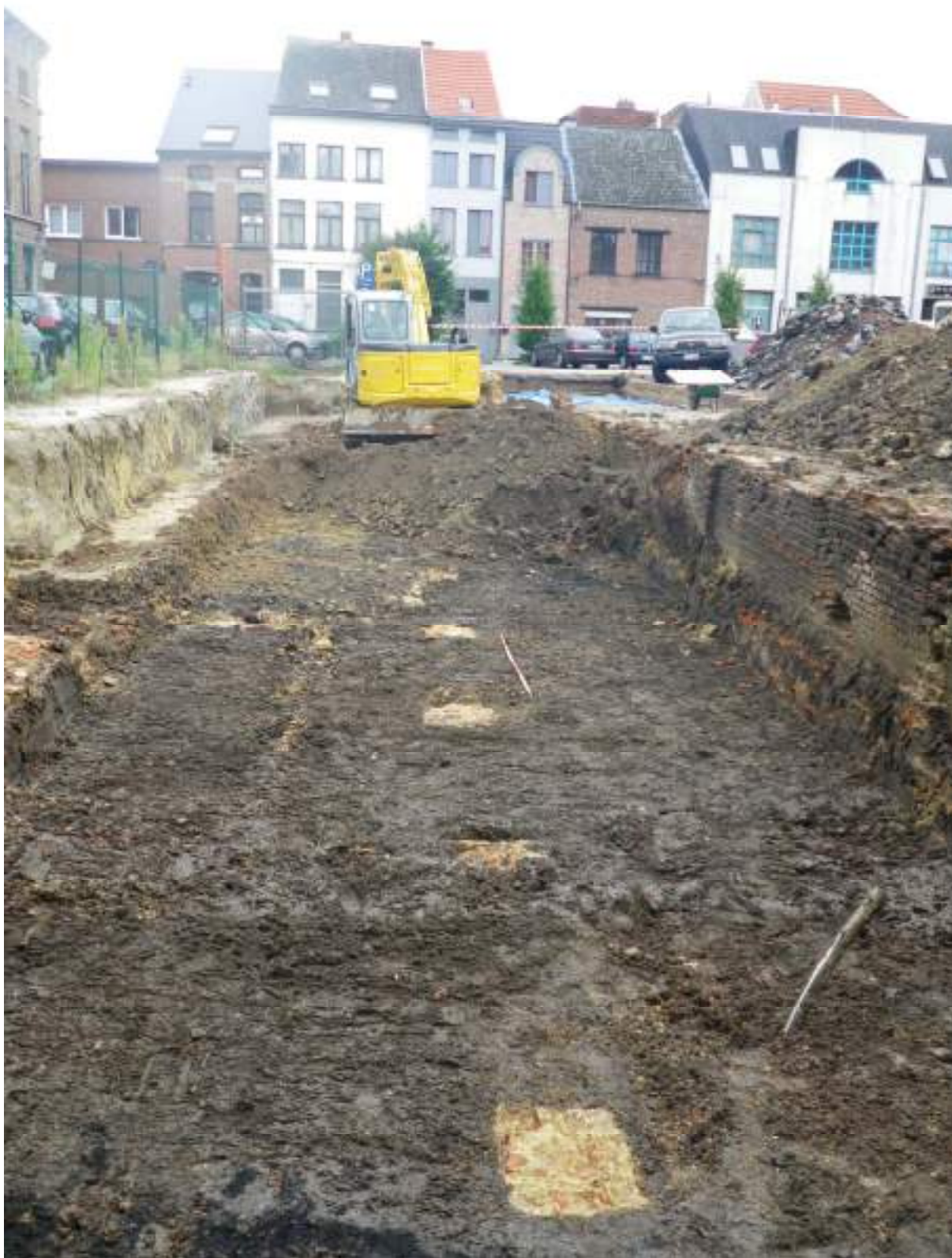
Figuur 3.3.5-73: algemeen zicht op de pijlers
