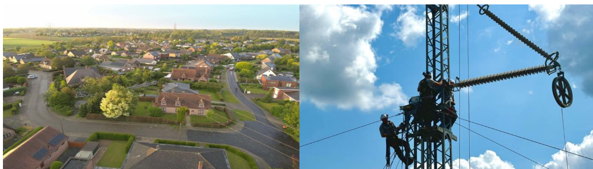
Luchtbeeld van de gevallen HS-lijn op de wijk Vinkstraat + werkzaamheden aan de noodlijn (ELIA)
