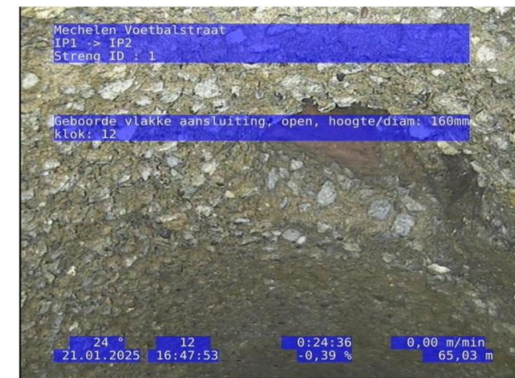
P_53459617_V237_2025-01-21_16451800.jpg, 00:24:33, 65.03m Geboorde vlakke aansluiting, open, hoogte/diam: 160mm klok: 12
