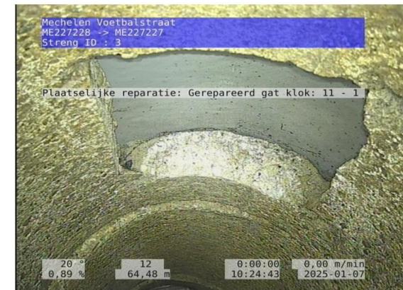
P_53459617_V219_2025-01-07_10262800.jpg, 00:39:35, 64.48m Plaatselijke reparatie: Gerepareerd gat klok: 11 - 1
